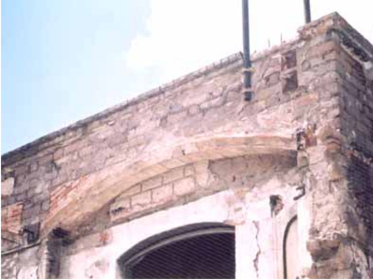
Detalle de la cubierta de la sala de motores. Nótese la bóveda tabicada, los entrepaños de adobe, las pilastras y el pretil de piedra, y el acabado original. Termoeléctrica de la Potosina Electric Co. Agosto de 2006.
