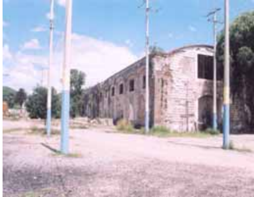
Vista general de la sala de motores. Termoeléctrica de la Potosina Electric Co. Agosto de 2006.
